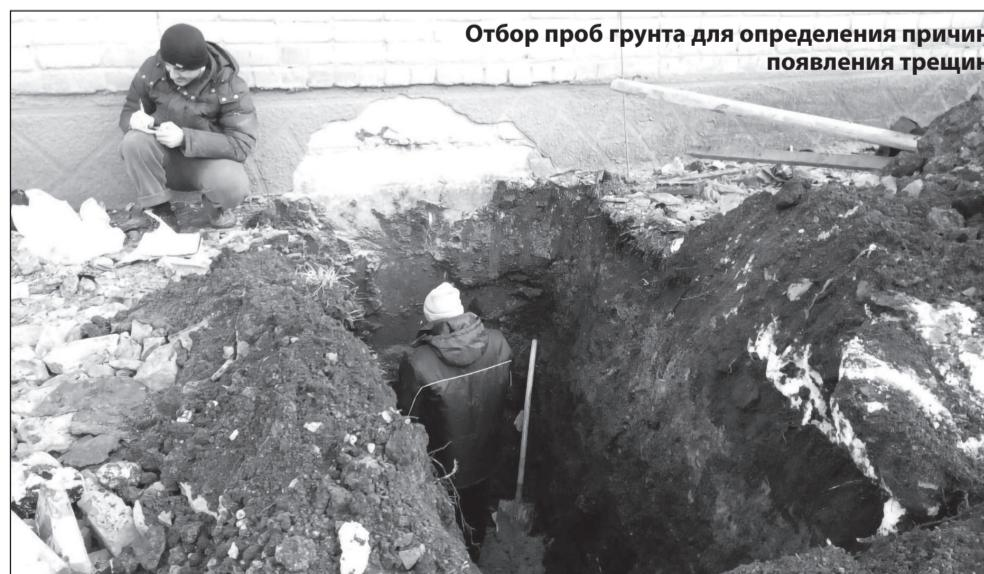
Отбор проб грунта для определения причин появления трещин
