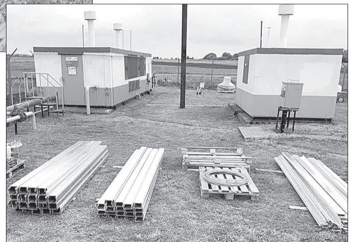
Подготовка лотка к монтажу ГРС Титово (Башмаковское ЛПУМГ)
