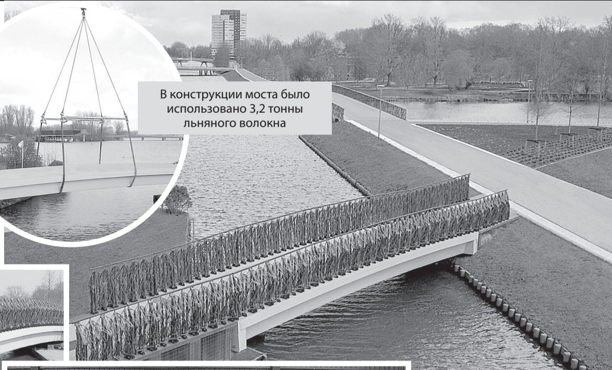
Перед установкой мост тестировался на прочность и жесткость
