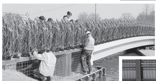
Перила также изготовлены из льна с помощью роботов
