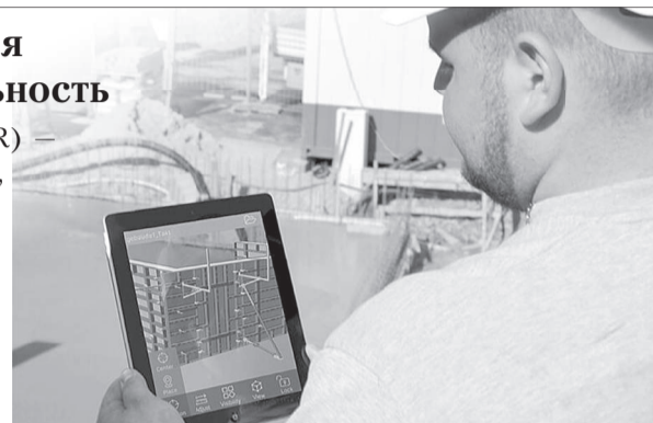
Приложение planitec AR от Paschal позволяет прямо со смартфона или планшета воссоздать проект опалубки в реальном окружении и оригинальном размере. Приложение на английском языке доступно бесплатно в App Store. Источник: Paschal
