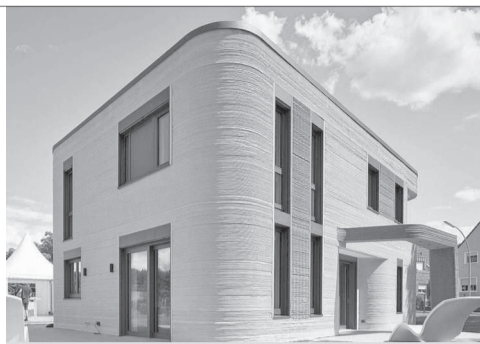
Проект 2021 года: первый жилой дом в Германии, полностью напечатанный на строительном принтере. Считается, что 3D-печать в основном предназначена для несущих конструкций, но здесь принтер сделал еще камин, лестницу и ванну. На весь дом ушло 13,5 часов. Расположен он в немецком городе Беккум, его площадь 160 м², подрядчиками выступили компании Peri 3d Construction и Heidelberg Cement Group. Источник: housedruck.de
